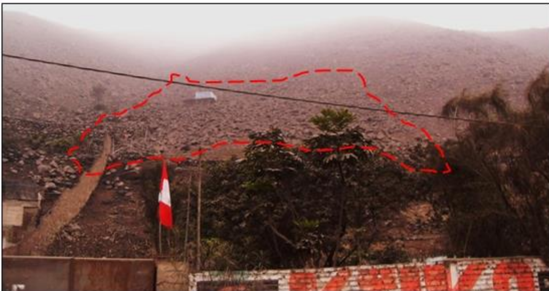
Figura 18: La línea segmentada de color rojo muestran caídas de rocas en el extremo norte del frontis de la planta de Sedapal.
