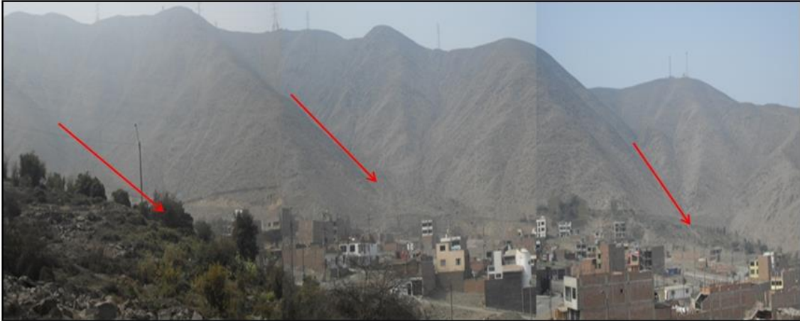
Figura 17: Las líneas segmentadas muestran el flujo de detritos en el extremo este de la Urb. Las Terrazas.
