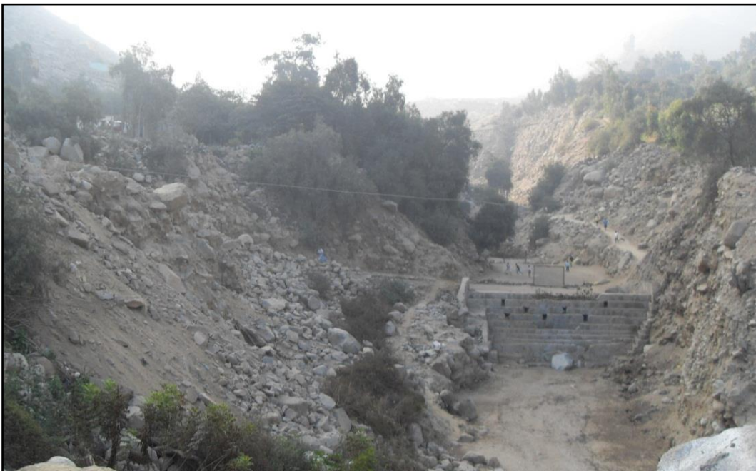
Figura 20: Quebrada Pedregal. Muros de contención y depósitos de flujos de detritos en ambos lados de la quebrada.
