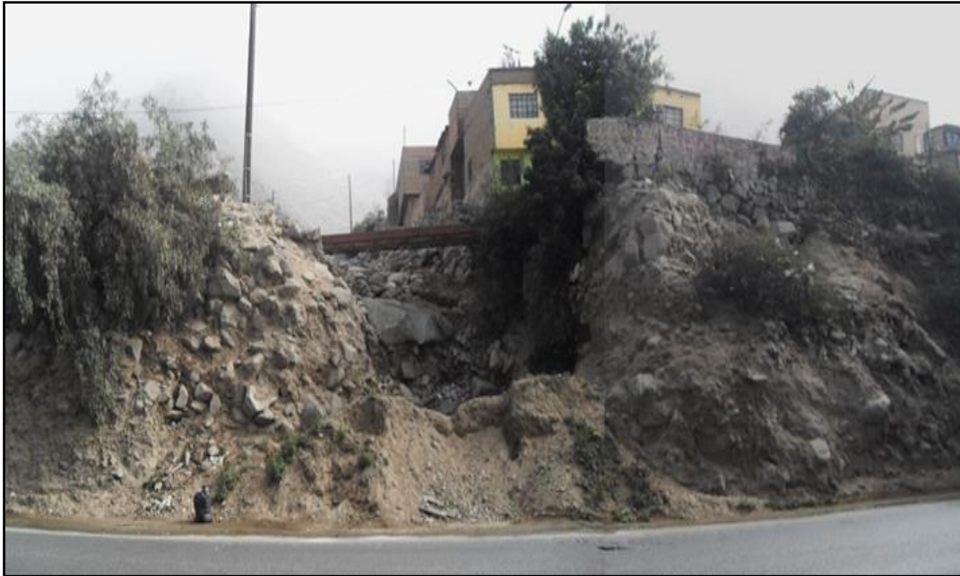
Figura 17: Quebrada Corrales que cruza la Carretera Central a la altura del Km 32 y que llega al río Rímac. Composición típica del material depositado por flujos de detritos con espesores de 10m
