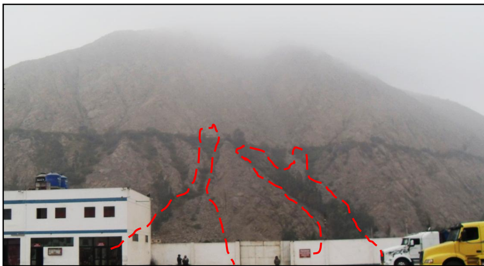
Figura 21: Derrumbes y caída de rocas en las inmediaciones de la Urb. Batasol, margen izquierda del río Rímac.
