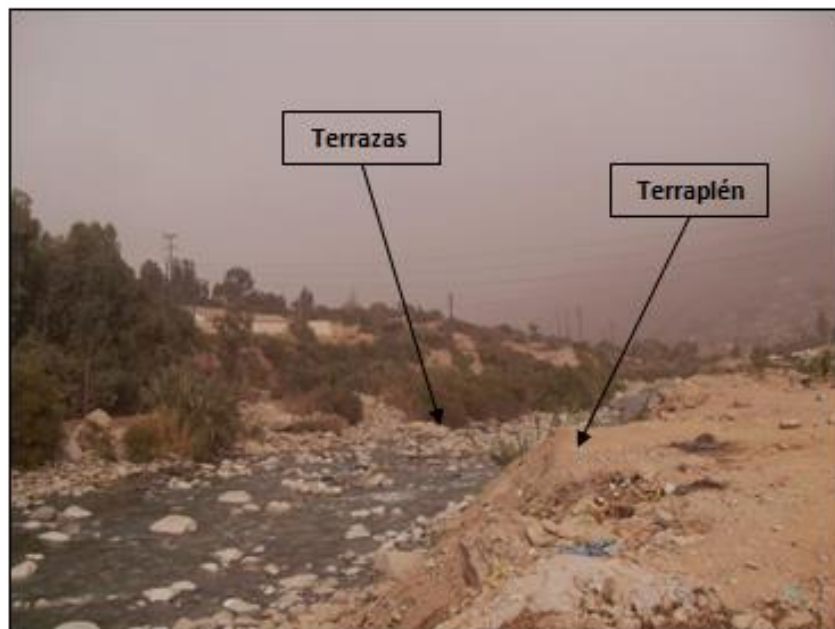
Figura 30: Río Rímac en época no lluviosa, caudal bajo, aguas claras. Terrazas con pendientes entre 15°-20° hasta 70°. Relleno de material de desmonte
