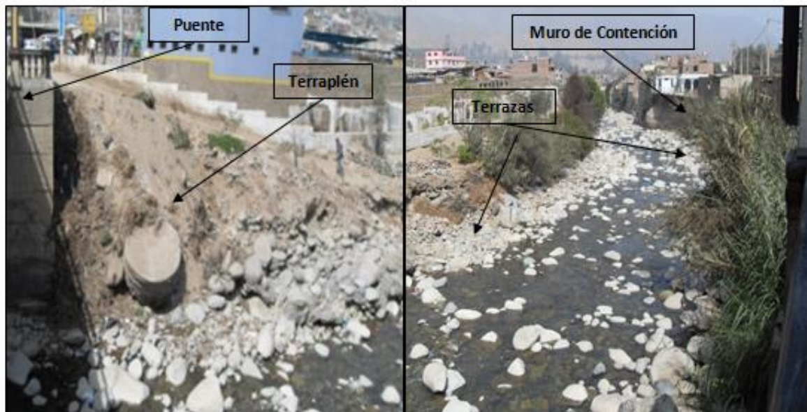
Figura 33: Puente construido sobre relleno antrópico y viviendas al mismo nivel del cauce del río.
