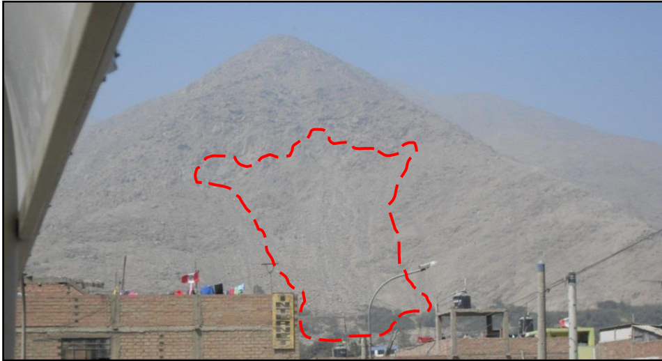
Figura 23: Caída de rocas en los alrededores de la Universidad La Cantuta, margen izquierda del río Rímac
