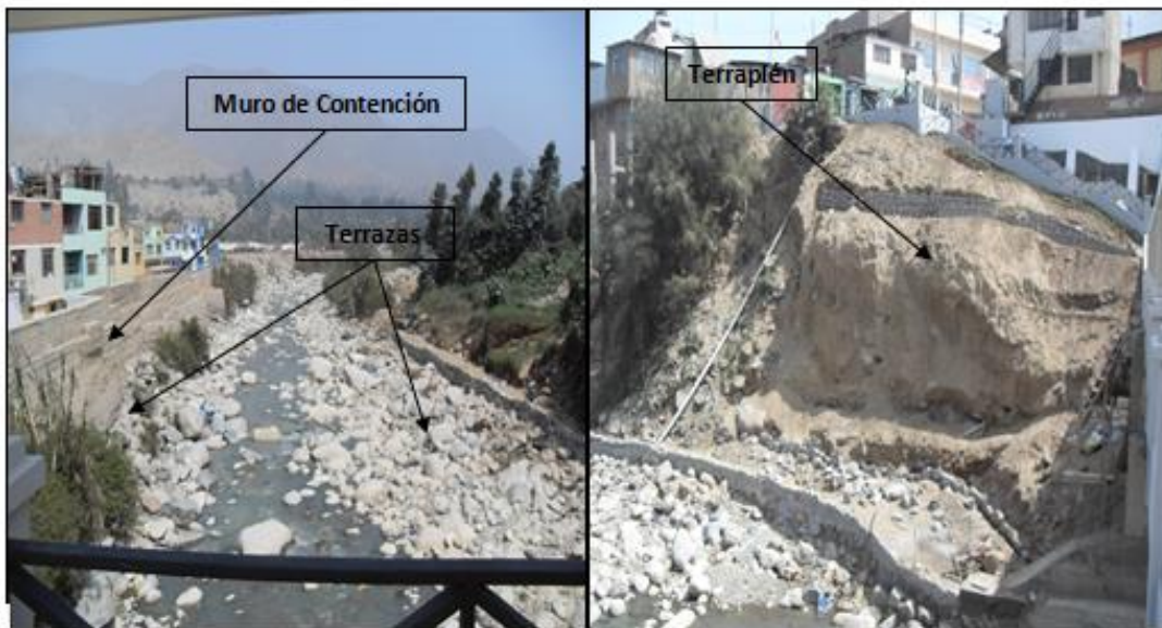
Figura 34: Viviendas construidas sobre depósitos aluviales (parte superior) y depósitos fluviales (parte inferior). Relleno antrópico depositado para cubrir zonas erosionadas por el río.
