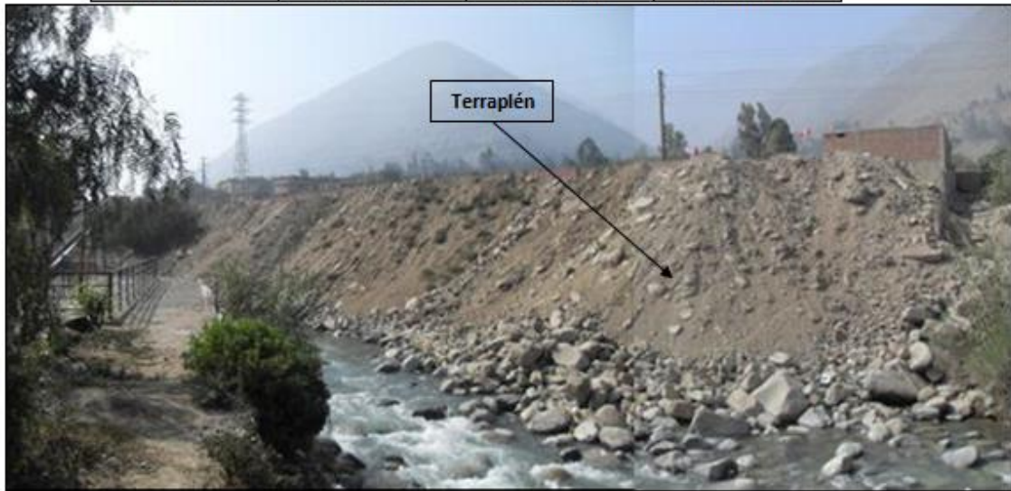
Figura 31: Relleno antrópico depositado para cubrir la zona de erosión del río.
