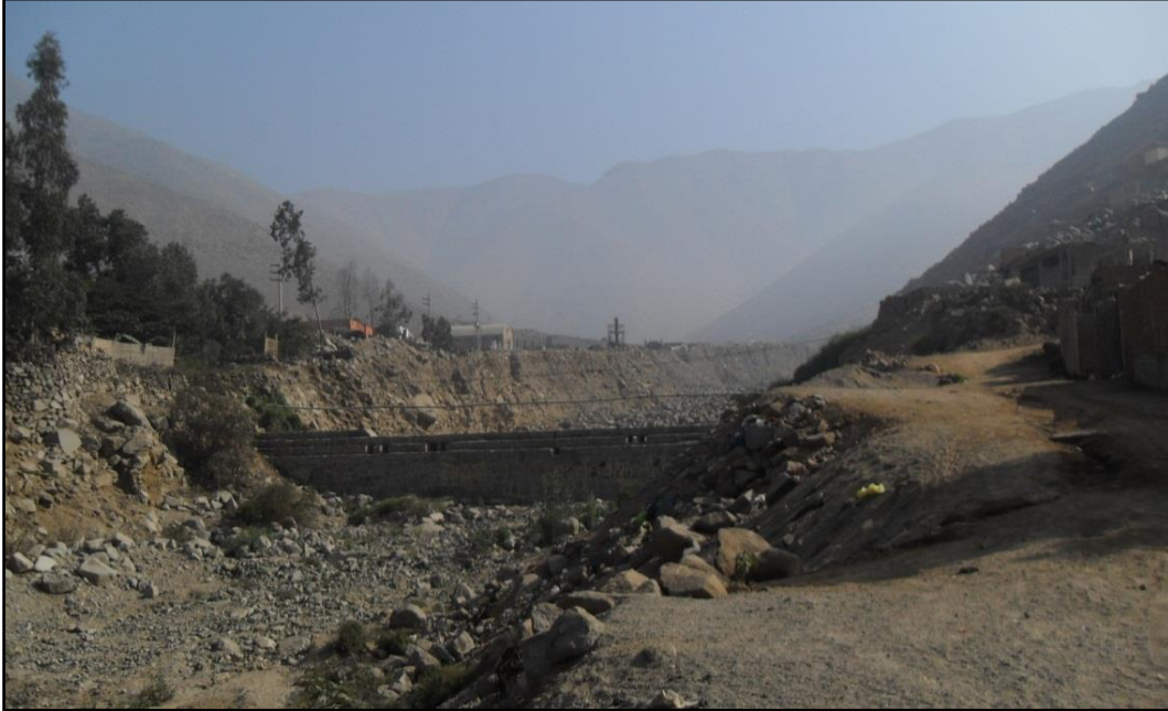
Figura 19: Quebrada Quirio. Muros de contención para retención de sólido a fin de evitar que los flujos de detritos alcancen la parte baja de la quebrada (Carretera Central), donde se encuentra la mayor parte de la población.
