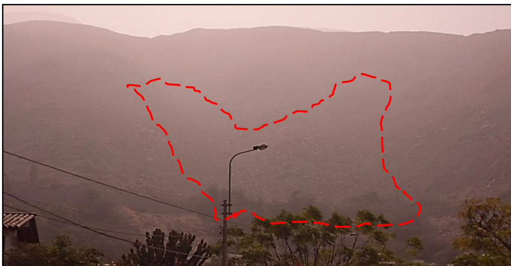
Figura 22: Caída de rocas en la Urb. Santa María, margen derecha del río Rímac
